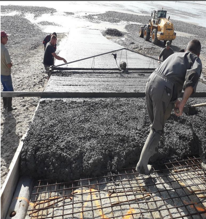
Béton tiré à la règle, puis vibré de façon homogène ... Au total pas moins de 45 m3 de béton utilisés (200 m2 couverts avec des épaisseurs de béton variant de 10 à 35 cm).
