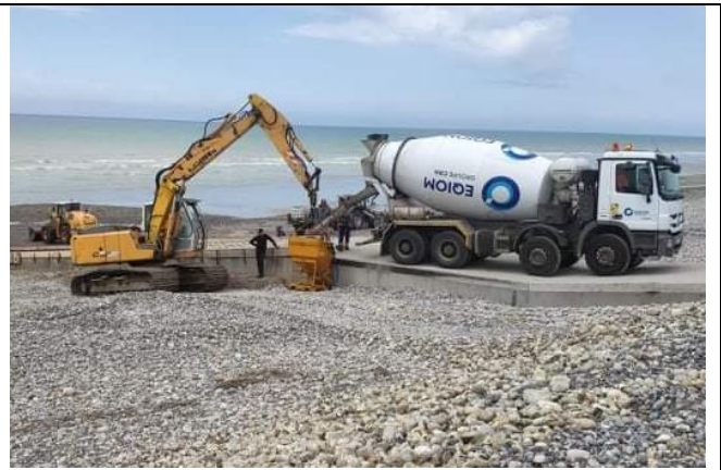
Un ensemble de moyens techniques : pelle hydraulique et godet associés à la réception des camions-toupies ; en arrière-plan un chargeur.
