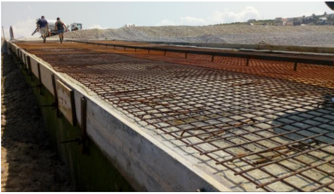
Réalisation d'un coffrage, de la pose de treillis soudés, 1 000 fers scellés chimiquement.
