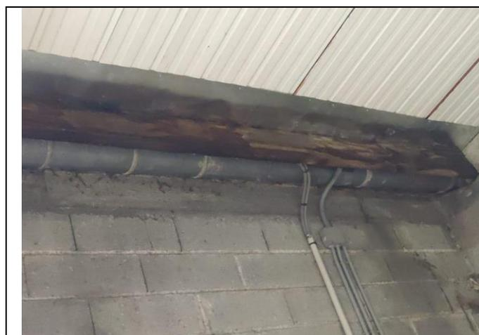
**Une infiltration d'eau aurait à terme fortement fragilisé une pièce de charpente**
