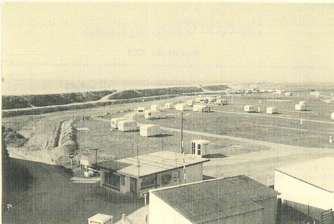
Les travaux de confortement de la digue derrière le camping se continuent à vive allure le Terre-plein d'environ 1 m 20 de haut sur lequel le parc à bateaux du Club des Pêcheurs Plaisanciers sera réinstallé ainsi que le fossé de drainage et le talus de séparation du camping devront être terminés pour fin juin afin de laisser l'espace libre aux vacanciers un local neuf sera construit par la suite près de la palissade d'Aut.
